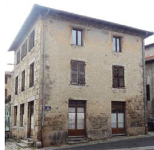
Enduit à la chaux + garde grain pierre en égout
