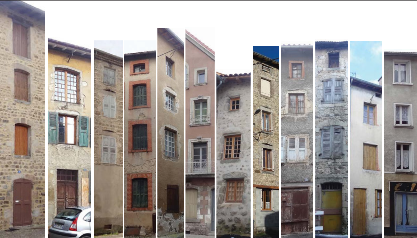
LES DIFFÉRENTES TYPOLOGIES D'ENCADREMENT DE BAIE
