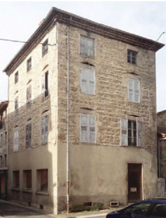
Maçonnerie pierre + lignage d'enduit et revêtement ciment à RDC
