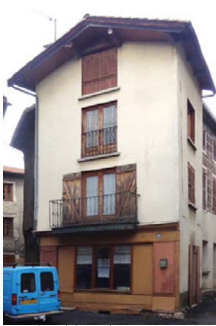
Maison à pan de bois, enduite
