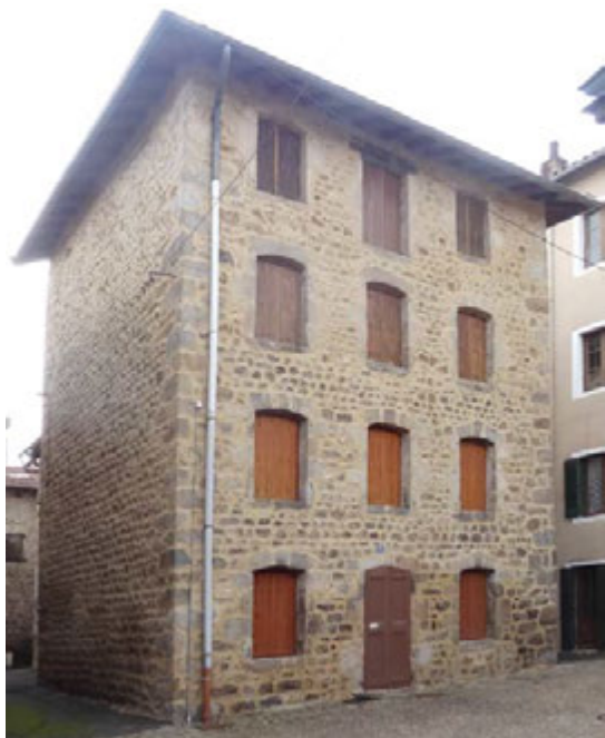
Maçonnerie joint beurré + tête de pierre apparente
