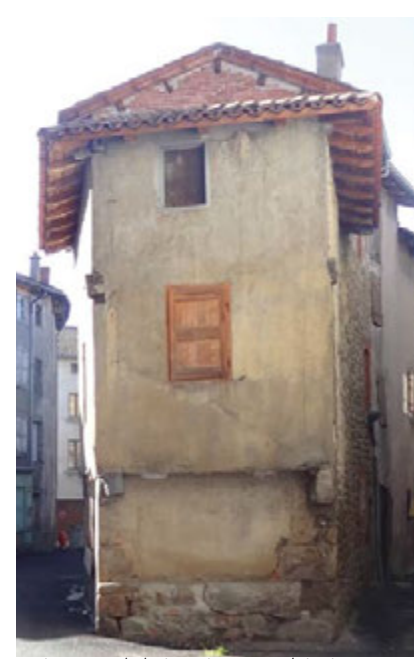
Maison pan de bois + pierre + enduit ciment
